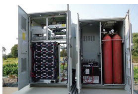
打造印度第一個以燃料電池為電源之通訊塔
