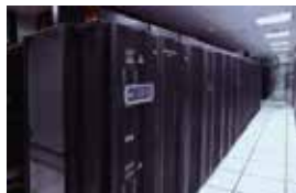
提供中国主要电信运营商数据中心及通信电源解决方案
