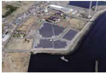
建置日本淡路岛装置容量达 2MWp 之太阳能光伏系统整合方案
