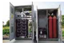
打造印度第一座以燃料电池为电源的通讯塔
