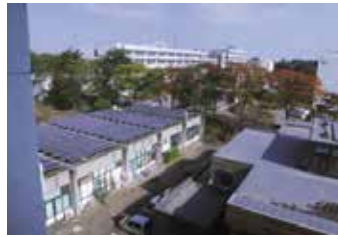
参与日本东北大学智能建筑项目，提供建筑节能管理
