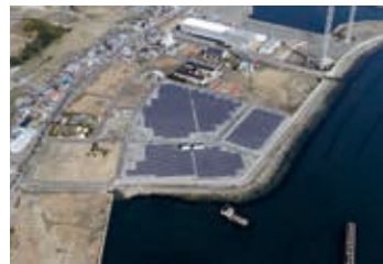
建置日本淡路岛太阳能光伏发电系统整合方案，装置容量达 2MWp
