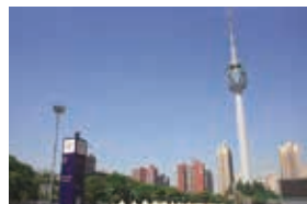
提供陕西广播电视塔包含 UPS、电力系统、服务器机柜、精密空调及环境管理系统等 InfraSuite 全套数据中心解决方案
