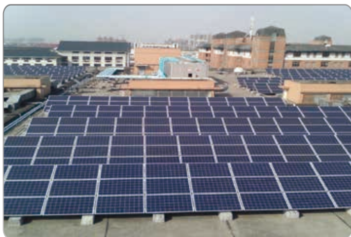
吴江厂区金太阳工程 -2.177MWp
