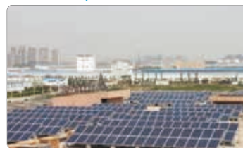
芜湖厂区金太阳工程 -1.53MWp
