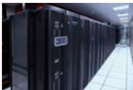
提供中国三大运营商 4G LTE 通信电源，建置 IDC 机房
