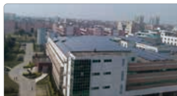
东莞厂区金太阳工程 -2.117MWp
