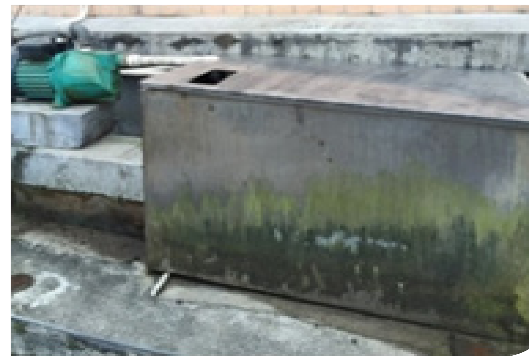
“RO”饮用纯净水系统废水回收
