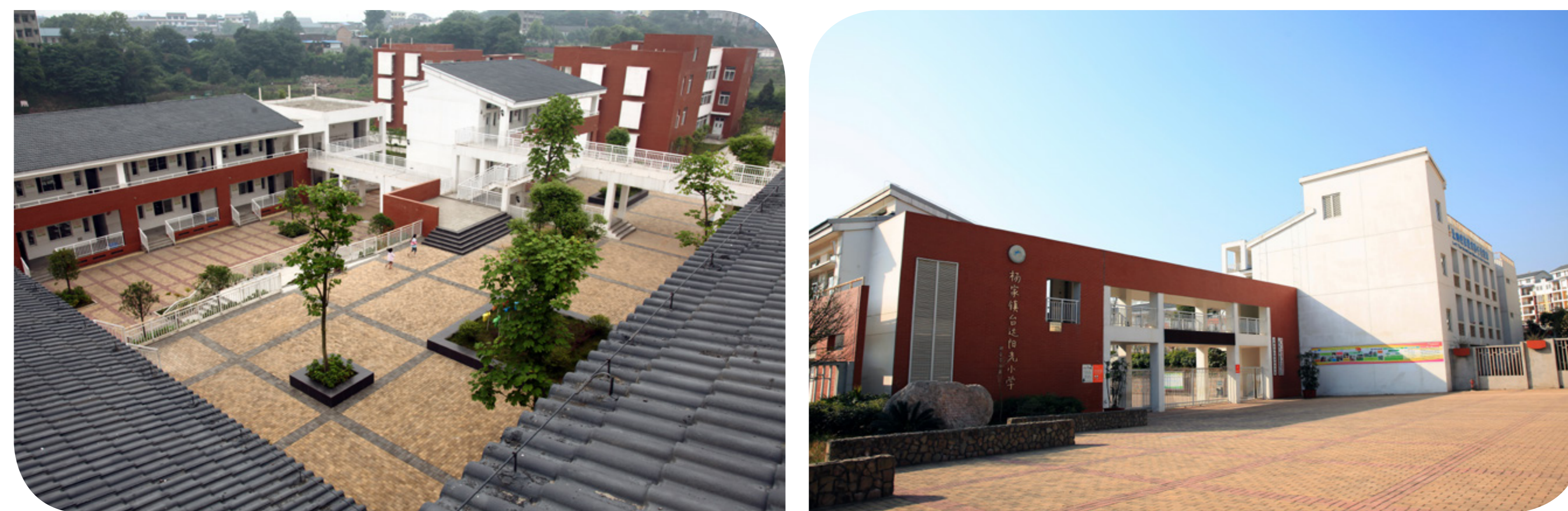
四川杨集镇台达阳光小学是汶川地震灾区第一所绿色建筑校园
