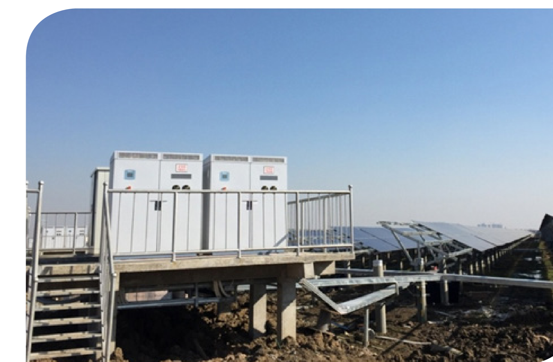
台达室外型500kW IP65防护等级集中式逆变器现场图
