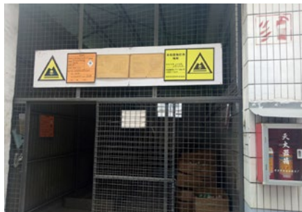
危险废弃物仓库
