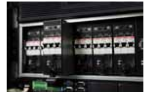
150kW机种可选配机架式精密配电模块, 断路器模块与控制模块 皆可支持热拔插
