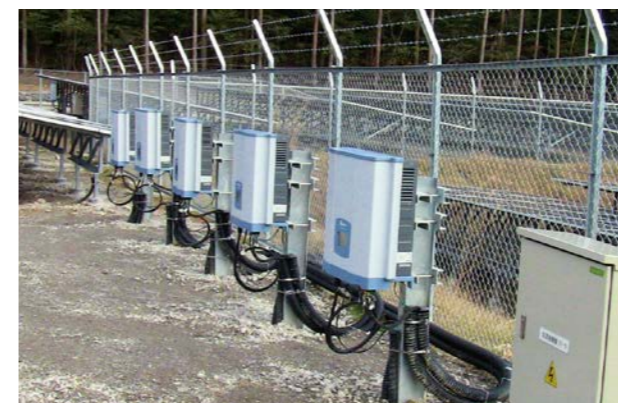
パワーコンディショナを風雨にさらし、さらに背面を南に向けて設置。過酷な条件下でのライフタイムテストです。
