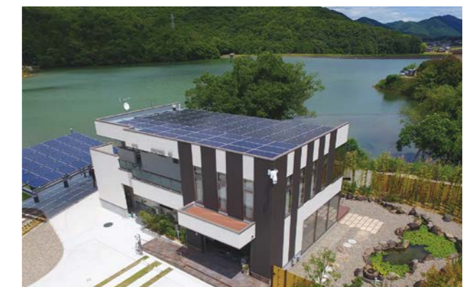
太陽光発電システムの実証試験棟。SBS(ビルの運用効率を改善する施策)を導入しており、平均で約33.8%もの省エネを達成。LEEDゴールドに認定されたグリーンビルです。
