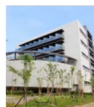
グリーンビルディング (LEED ゴールド取得)
