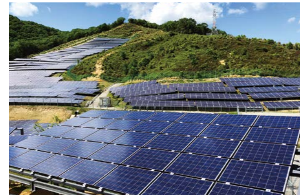
あえて方位にこだわらず、波打つ地面に沿って太陽電池を設置。真南に向けて設置したシステムとの発電量の違いをチェックしています。
