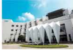
台南研發中心 (鑽石級綠建築)
