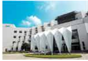
台南研發中心 (鑽石級綠建築)
