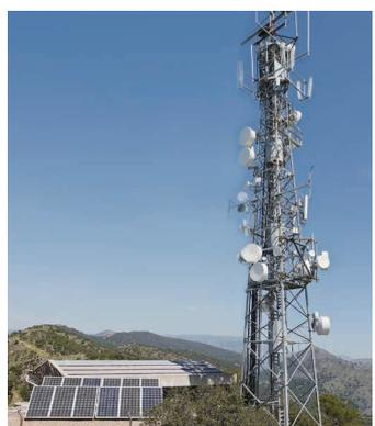
提供非洲電信營運商整合太陽能發電系統的戶外通信電源解決方案
