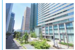
樓宇管理控制系統為寧波宏泰廣場打造智能樓宇
