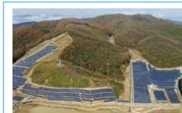
在日本赤穗打造裝置容量 4.6MW 的分散式系統，搭配儲能系統，平滑化發電輸出
