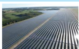
為總裝置容量達75.4MW的丹麥太陽能發電計畫提供高效太陽能逆變器
