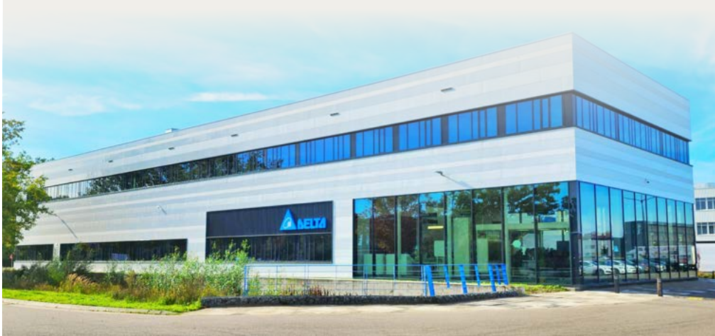
台達位於荷蘭 Helmond Automotive Campus 辦公大樓取得 LEED 黃金級綠建築認證
