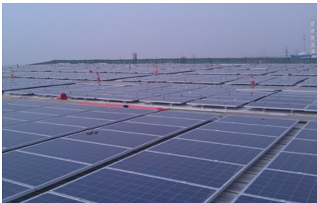
建设中的工程现场实景
